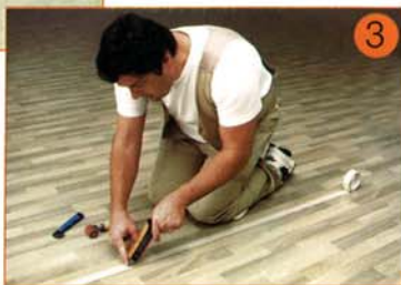
Presser la buse profondément dans le joint avec une main. La déplacer le long de la coupe et doser avec la seconde main le produit de soudure à froid, de manière à générer un cordon d'environ 5 mm sur la bande adhésive.
