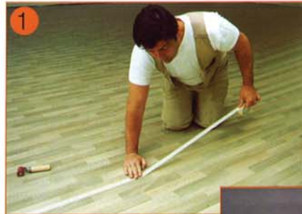
Centrer et coller la bande de papier cache adhésive spéciale avec un rouleau de pression.
