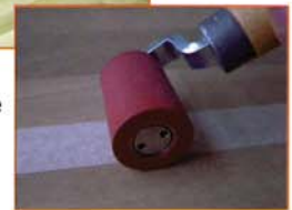
Centrer et coller la bande de papier cache adhésive spéciale avec un rouleau de pression.
